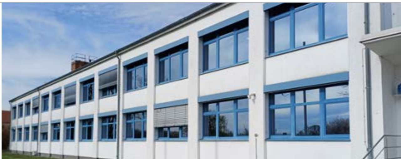
3 Verwaltungsbäude Fassade zur Straße
