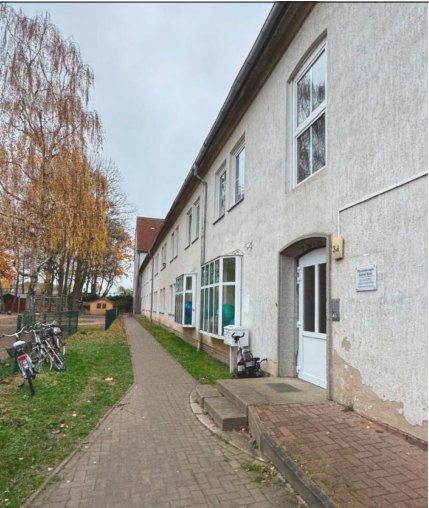
28 Blick auf den Fußgängerzugang zum Wohnheim
