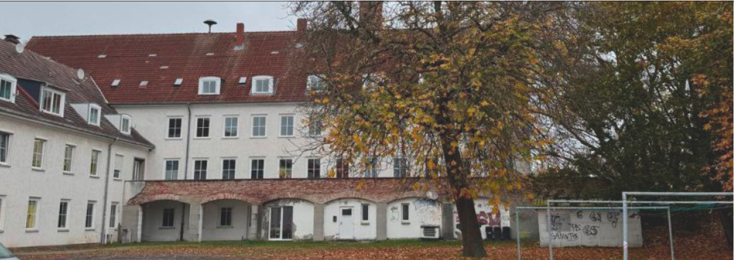
30 Innenhof des Wohnheims
