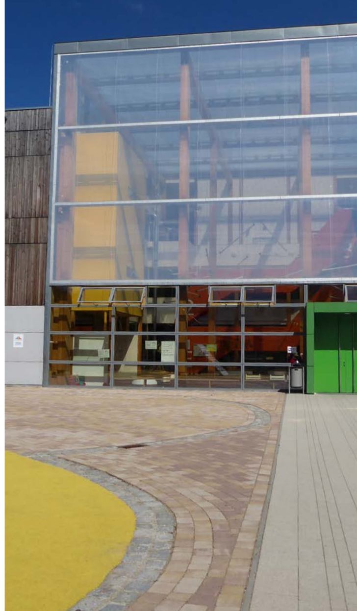
Bauen mit Bestand, Ansicht Gebäudehülle Plus Energie Schule Rostock
