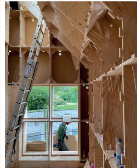
17 Digital gefertigtes Stecksystem
