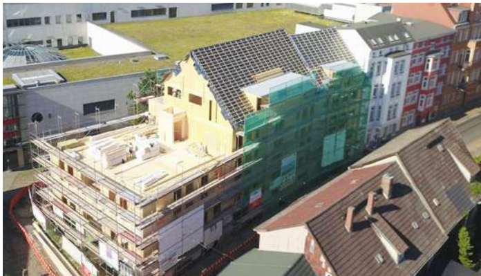
Bauphase, Foto: © Vitali Shembrowskij, Schwerin
