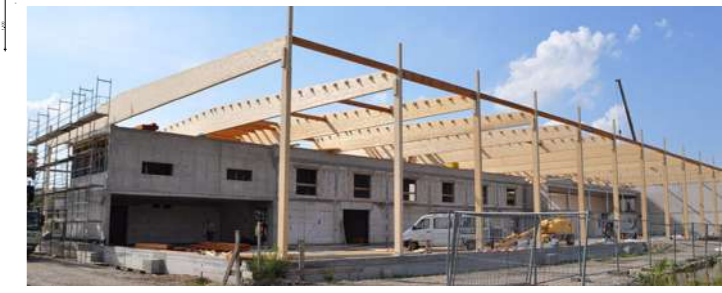
Bauphase, Foto: © Lehrecke Witschurke Architekten, Berlin
