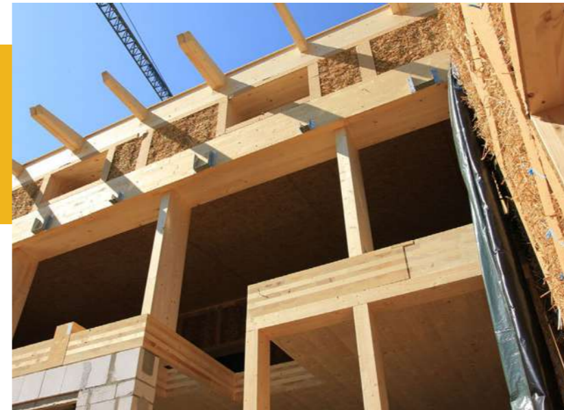
Bauphase – Holzkonstruktion, Foto: © Dag Schaffarczyk, Berlin
