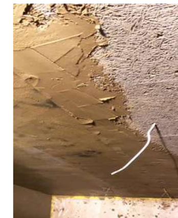
Bauphase Lehmputz auf Heizmatten, Foto: © Dag Schaffarczyk, Berlin
