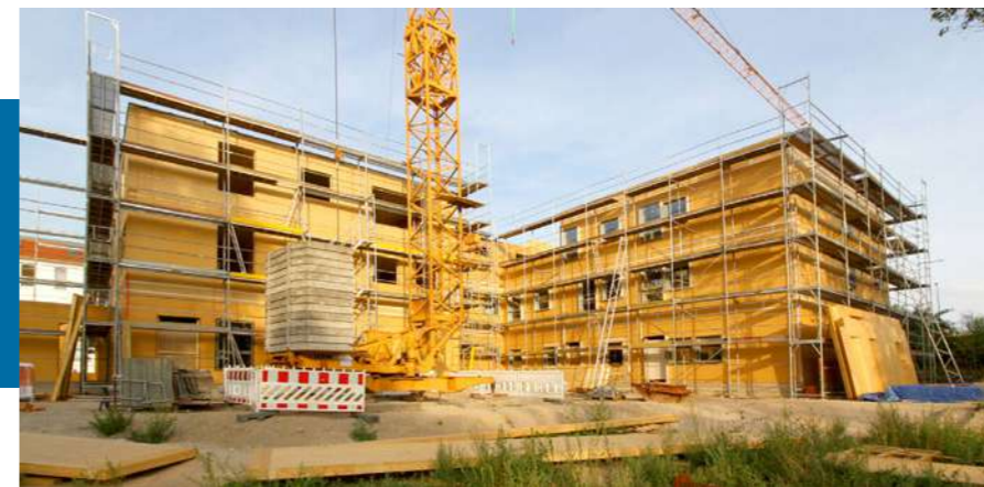
Bauphase, Foto: © FREIORT ARCHITEKTEN, Boltenhagen
