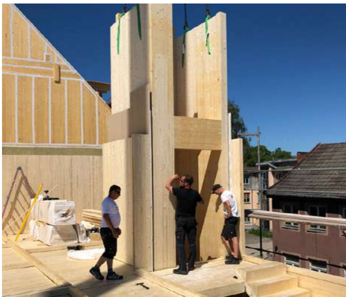
Bauphase, Foto: © Uwe Herring (Galileo Home GmbH & Co. KG, Fockbek)
