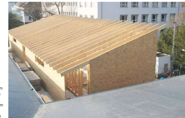
Bauphase – Sparrenkonstruktion des Pultdachs Ergänzungsbau Nordost, Foto: © Peter Schenk
