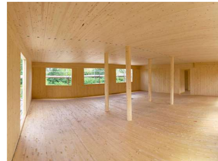
Bauphase, Foto: © Vitali Shembrowskij, Schwerin
