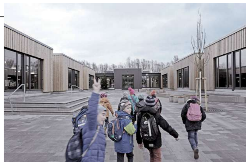
Zentraler Schulhof mit Pausen- und Spielbereich, Foto: © W&amp;V Architekten GmbH, Leipzig/ Berlin
