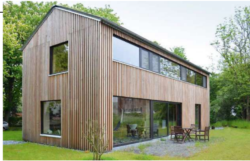
Außenansicht, Foto: © Scheuring u. Partner Architekten mbB, Köln
