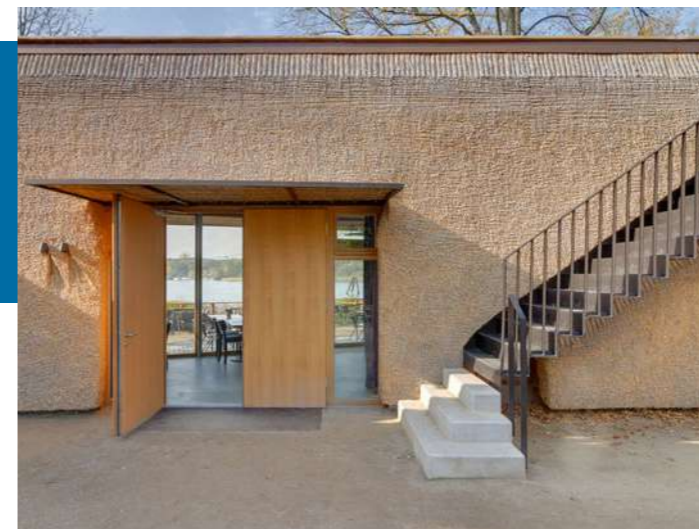
Außenansicht Eingang Anbau, Foto: © Johannes Kottjé
