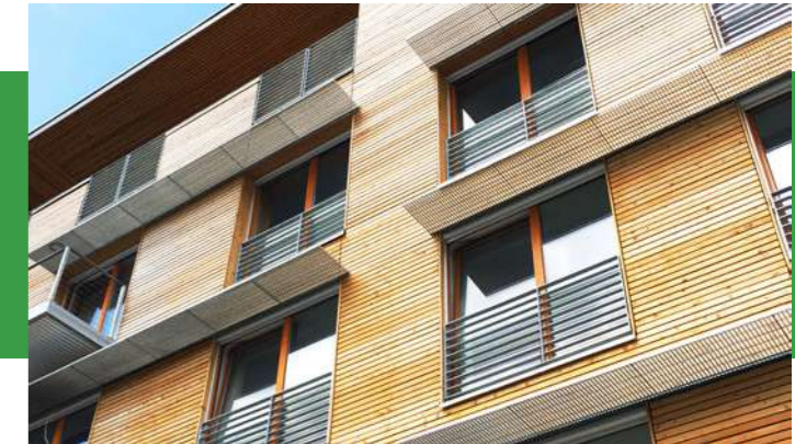
Außenansicht Fassade / Sonnenschutz, Foto: © rutsch+rutsch gbr architektur+szenografie, Schwerin
