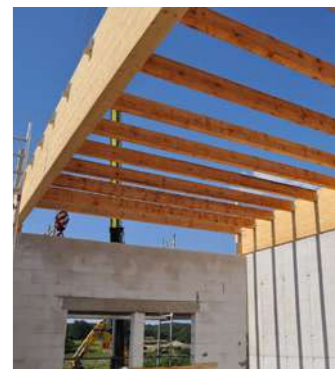
Bauphase, Foto: © Lehrecke Witschurke Architekten, Berlin
