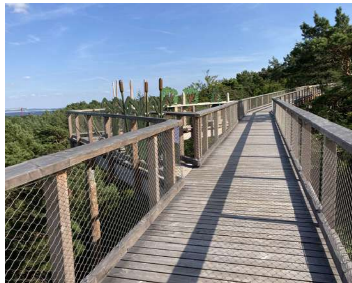
Ansicht Steg, Foto: © stöger-kölbl architekten gmbh, Schönberg
