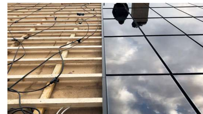
Bauphase Solardach, Foto: © Dag Schaffarczyk, Berlin
