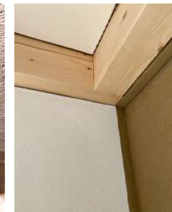
Lehmputz, Holzbalkendecke, Foto: © Dag Schaffarczyk, Berlin
