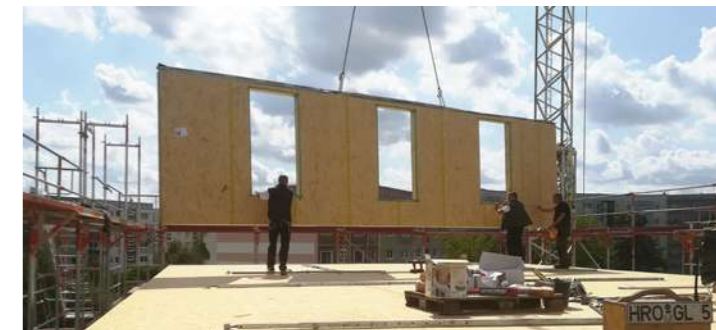
Bauphase, Foto: © matrix architektur gmbh, Rostock
