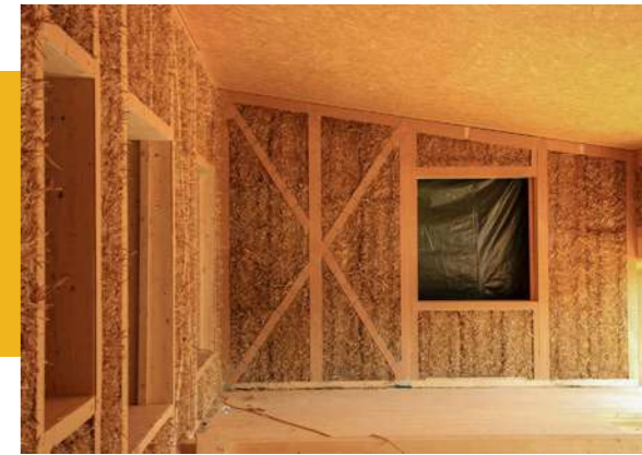
Bauphase – Außenwände aus Stroh, Foto: © Dag Schaffarczyk, Berlin
