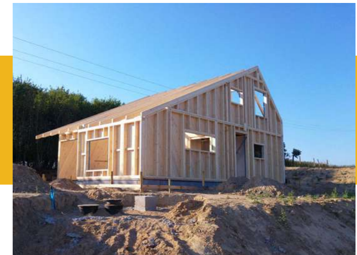
Bauphase Haus Malsehn, Foto: © René Witt
