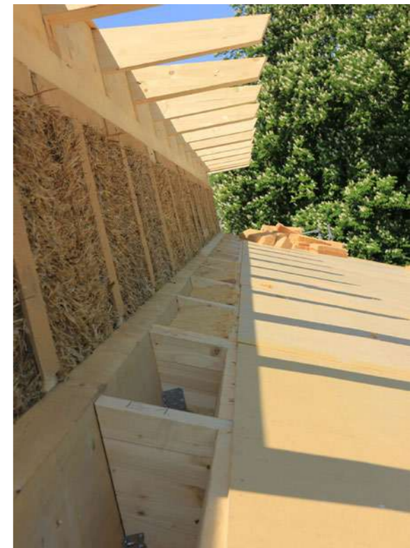
Bauphase – Detail Dach, Foto: © Dag Schaffarczyk, Berlin
