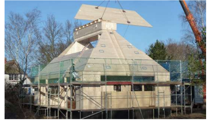
Bauphase, Foto: © Straub Beutin Architekten, Berlin
