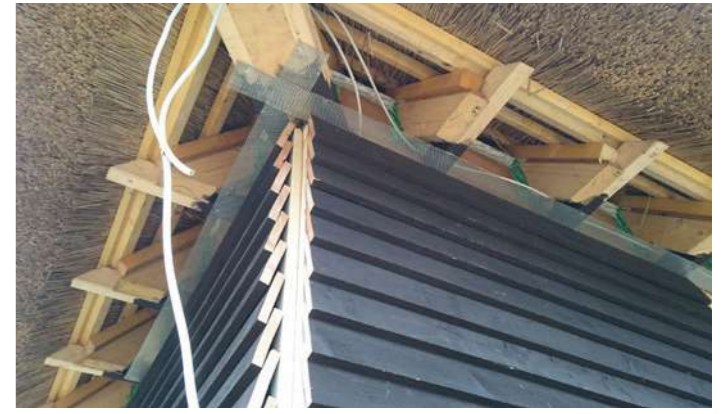
Bauphase, Foto: © Straub Beutin Architekten, Berlin
