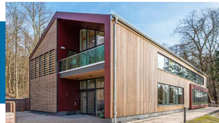
Ansicht Eingangsbereich, Foto: © gmw planungsgesellschaft mbH Thomas Wilhelm, Stralsund
