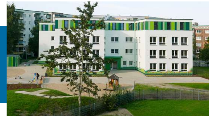
Nach der Sanierung, Foto: © Anja Schlamann
