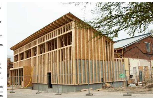
Bauphase – Holztragwerk Ergänzungsbau Nordost, Stahlbetonwände der Kammerbühne (aus akustischen Gründen), Foto: © Lucia Oberfrancová
