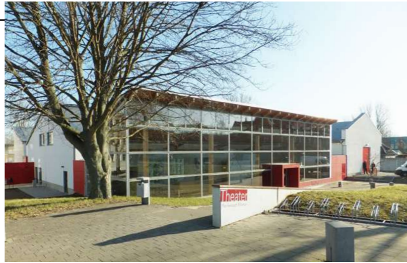
Außenansicht Haupteingang Foyeranbau Südwest, Foto: © Lucia Oberfrancová
