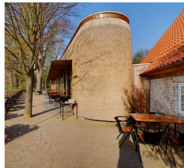
Außenansicht Verbindung Altbau Anbau, Foto: © Johannes Kottjé
