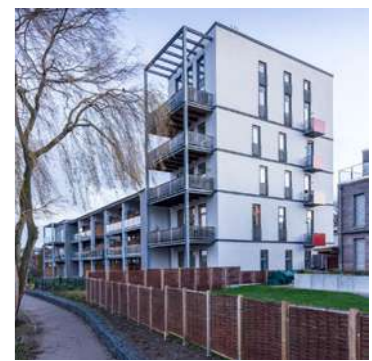
Außenansicht saniertes Sudhaus mit Siloturm, Foto: © Jörn-Lehmann-Photographie, Zittow
