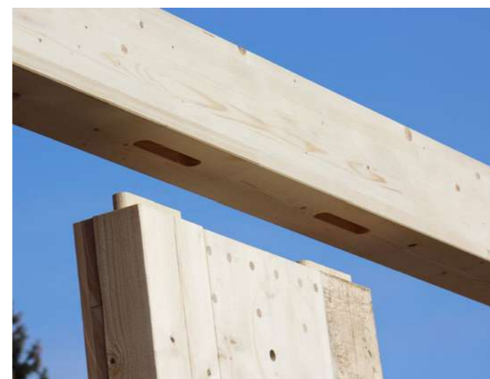
Bauphase Holzkonstruktion, Foto: © Dag Schaffarczyk, Berlin
