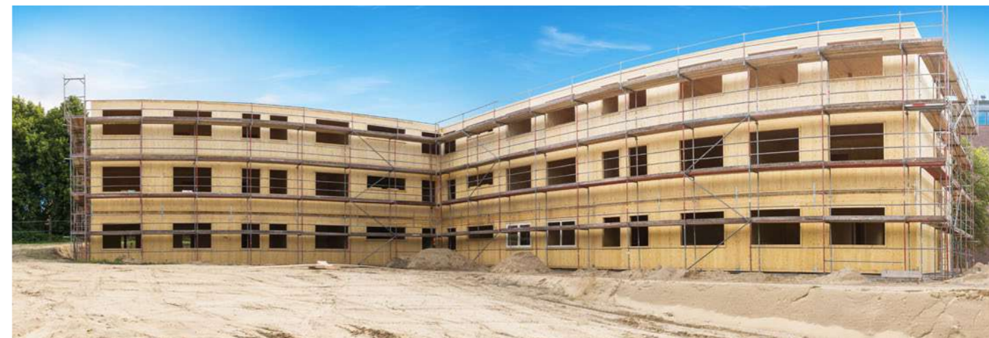
Bauphase, Foto: © Vitali Shembrowskij, Schwerin
