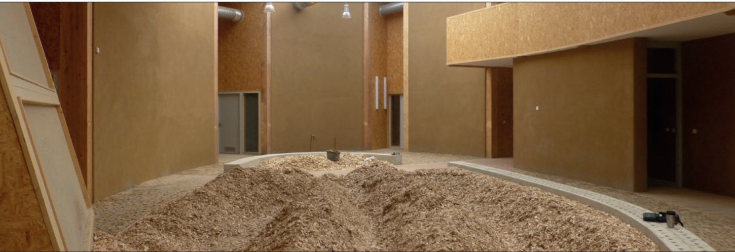
113 Innenhof während der Bauphase
