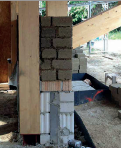
56 Ringbalken der Lehmwände
